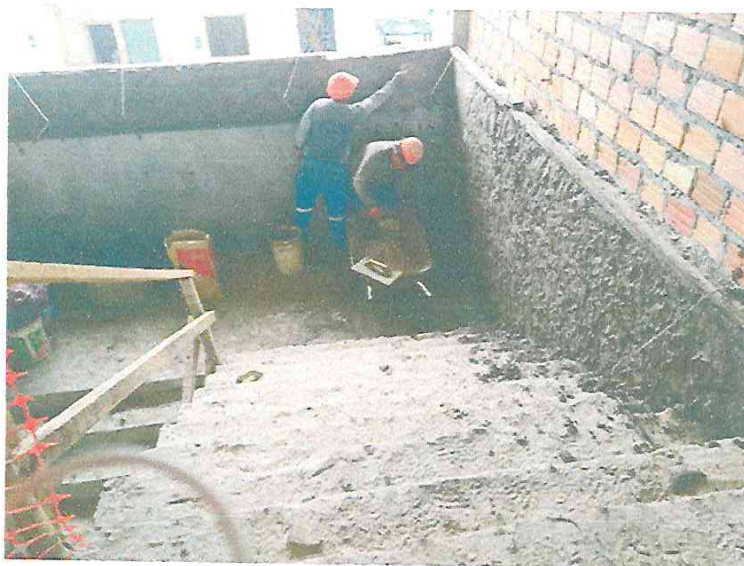
EMPASTADO DE COLUMNAS
