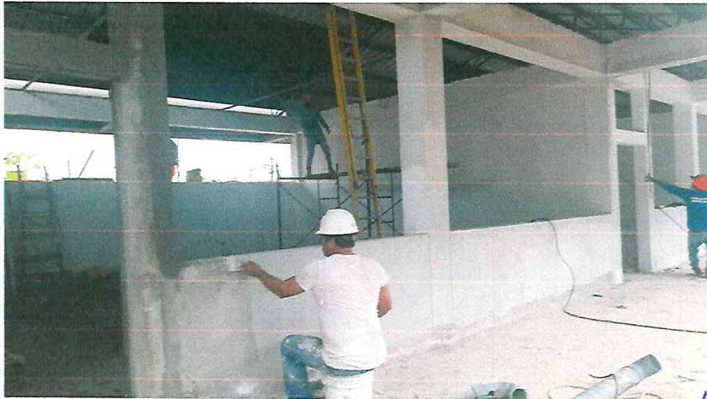
EMPASTADO DE MUROS Y COLUMNAS
