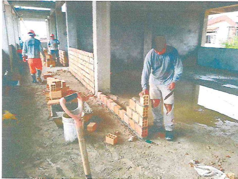
ASENTADO DE LADRILLO EN MUROS INTERIOR SEGUNDO PISO
