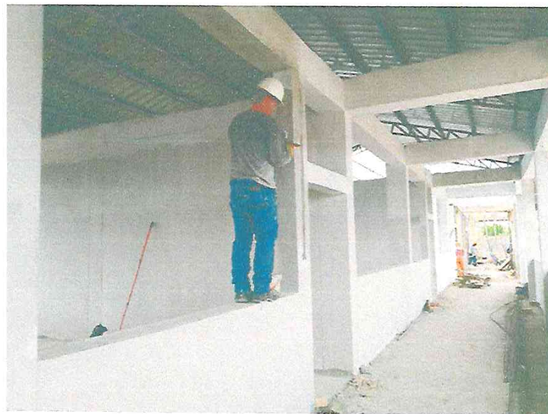
EMPASTADO DE COLUMNAS
