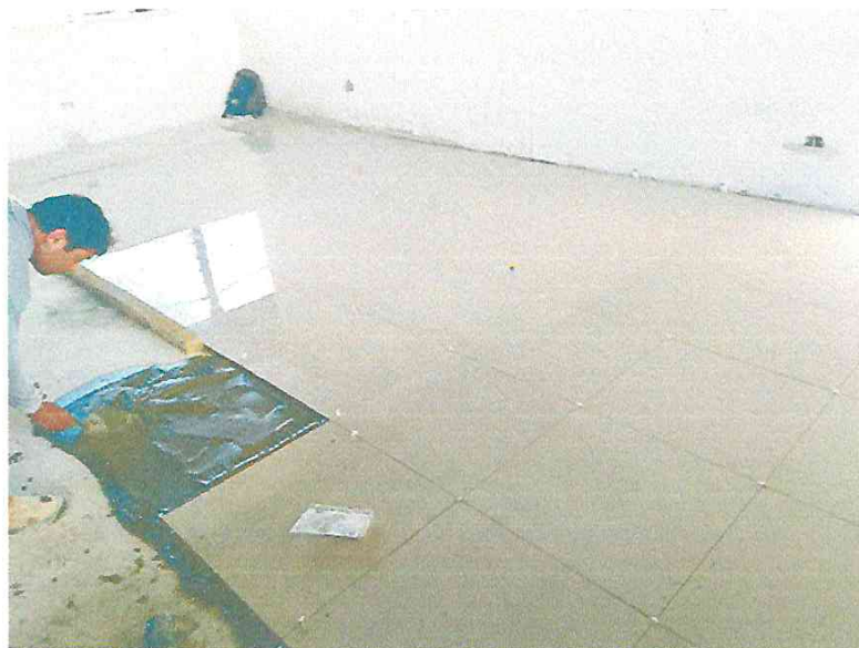
COLOCACION DE PORCELANATO DE ALTO TRANSITO EN PISO
