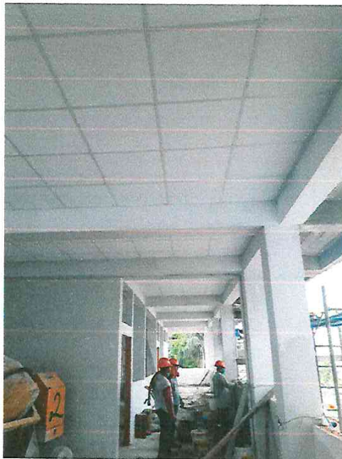
BALDOSAS – CIELORASO PASADIZO
