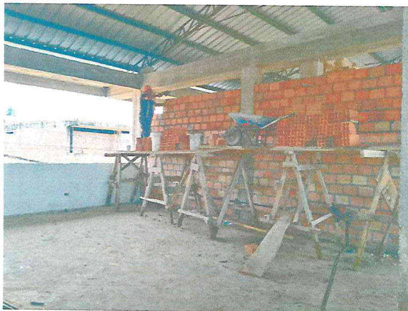
ASENTADO DE LADRILLO EN MUROS INTERIOR SEGUNDO PISO
