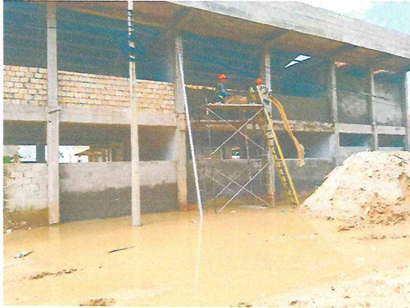
TARRAJEO DE MUROS Y COLUMNAS EXTERIOR
