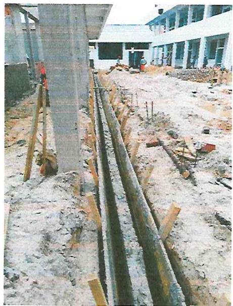
DESENCOFRADO DE CANALETAS
