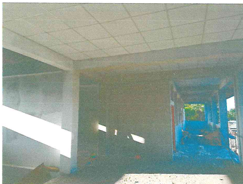
CIELORASO DE BALDOSA SUSPENDIDOS CON PERFILES
