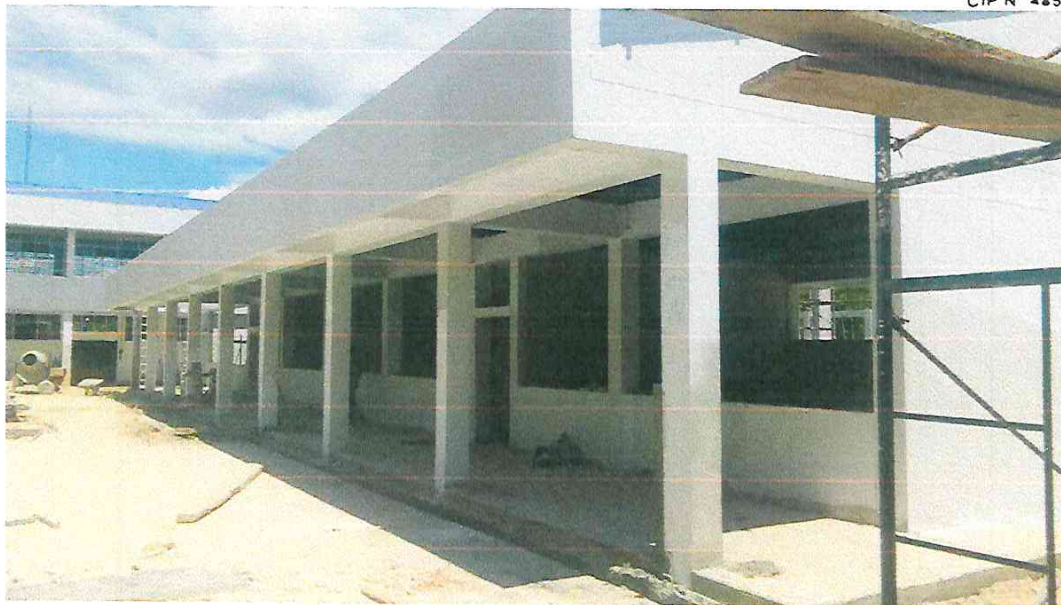
PINTADO DE COLUMNAS, VIGAS Y MUROS
