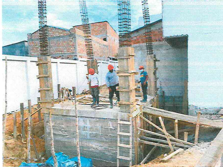
ENCOFRADO DE COLUMNAS DE TANQUE ELEVADO
