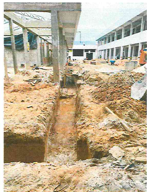
ENCOFRADO Y VACEO DE CUNETAS
