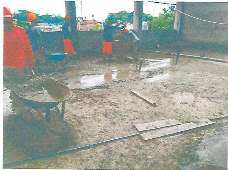
VACEO DE CONTRAPISO DE SEGUNDO PISO
