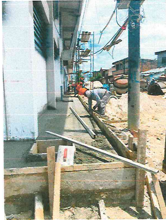
FROTACHADO DE VEREDAS EXTERIORES
