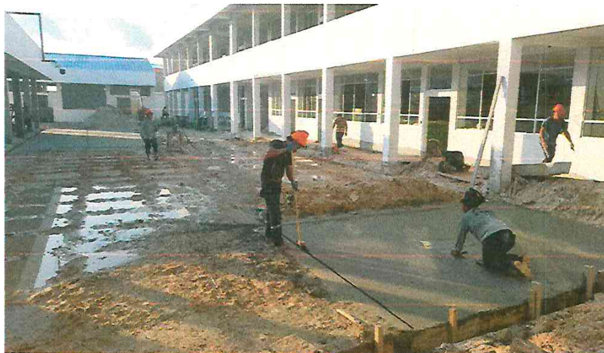
BRUÑADO – PATIO FORMACION
