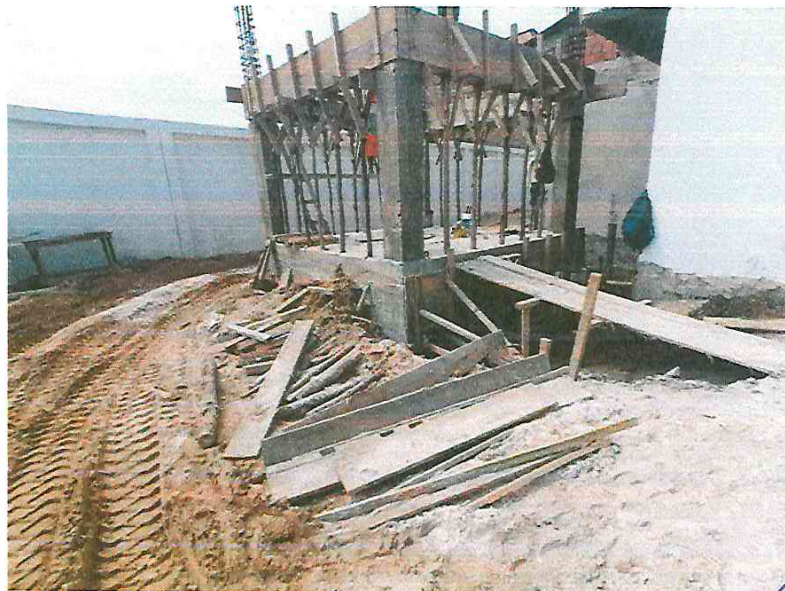
VACEO DE VIGAS DE TANQUE ELEVADO
