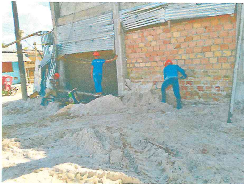
TARRAJEO DE MUROS Y COLUMNAS EXTERIOR
