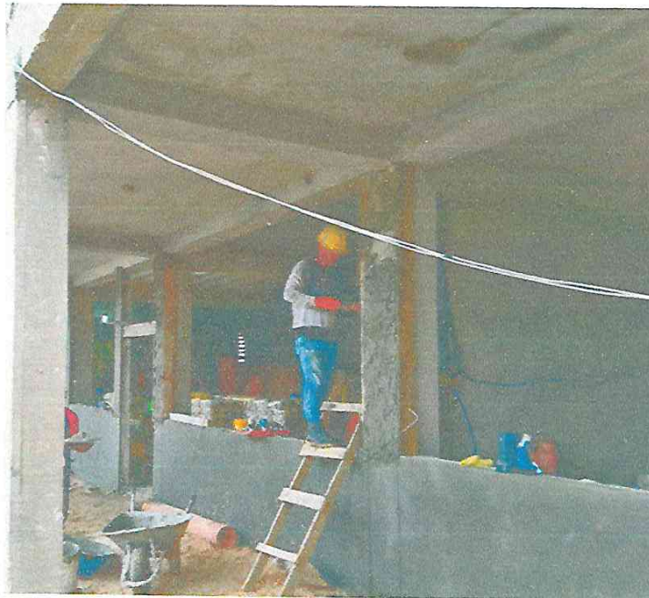
TARRAJEO FROTACHADO EN VIGAS Y COLUMNAS
