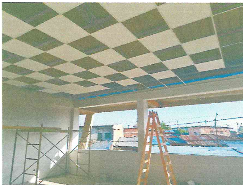
CIELORASO DE BALDOSA SUSPENDIDOS CON PERFILES
