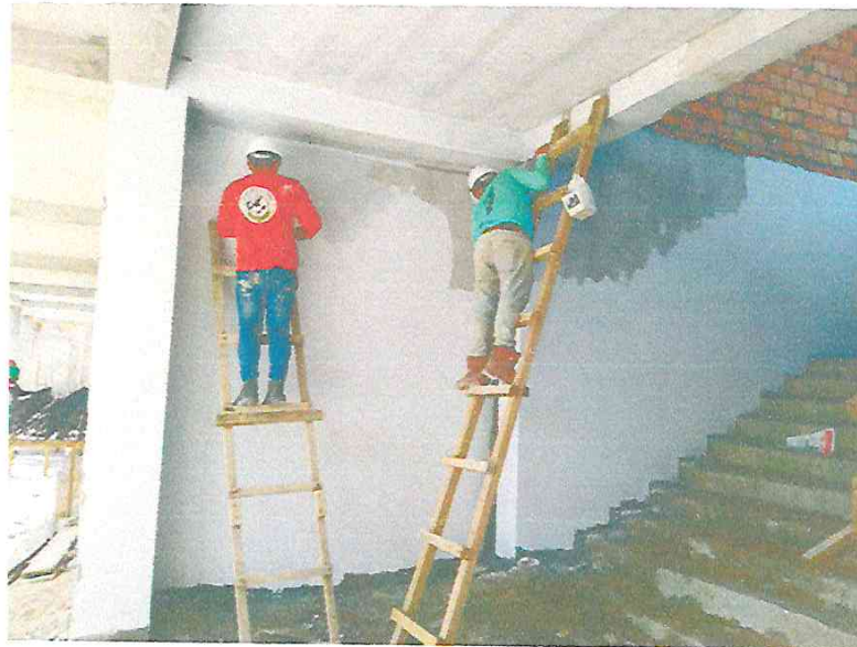
EMPASTADO Y PINTADO DE MUROS Y VIGAS
